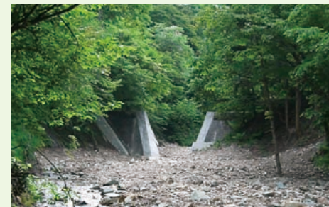
茂倉沢2号ダム
